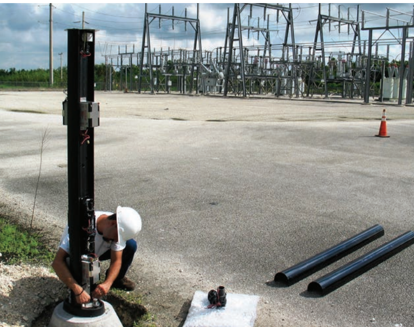
Instalacion subestacion de la ciudad de Homestead
